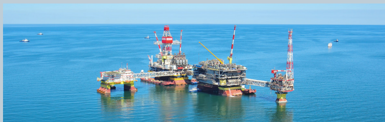
БЛОКИ ХРАНЕНИЯ И ЗАКАЧКИ ХИМРЕАГЕНТОВ И МЕТАНОЛА ОСВИДЕТЕЛЬСТВОВАНЫ НА СООТВЕТСТВИЕ ТРЕБОВАНИЯМ РОССИЙСКОГО МОРСКОГО РЕГИСТРА СУДОХОДСТВА.
