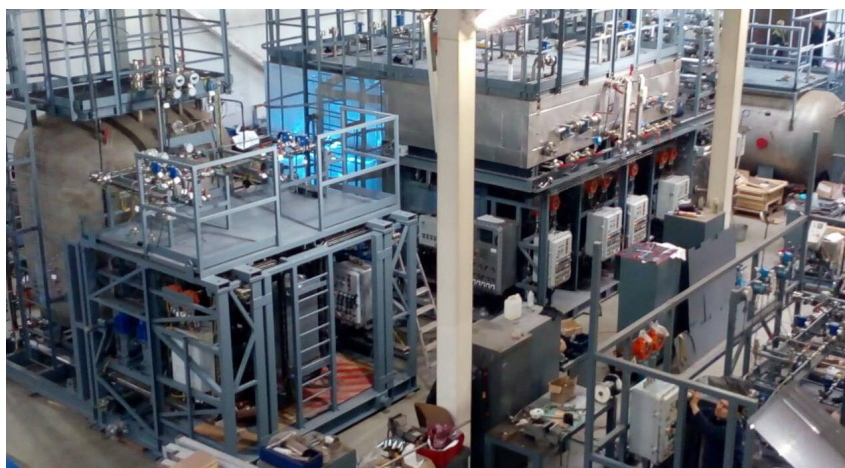
Блок хранения и закачки метанола и химреагентов
